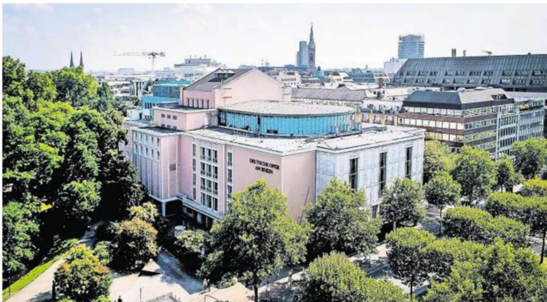
Sie soll abgerissen und am gleichen Standort durch einen Neubau ersetzt werden: die Deutsche Oper am Rhein. In der Politik gehen die Meinungen über das Projekt weit auseinander.
