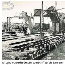
Am Land wurde das Gestein vom Schiff auf die Bahn umgeladen.
