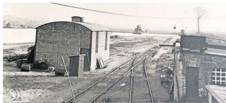
Die Bahn, die in Eller einen Bahnhof betrieb, verlegte nach dem Krieg eine kleine Nebenstrecke bis an den See. Das erleichterte die Arbeiten enorm.
