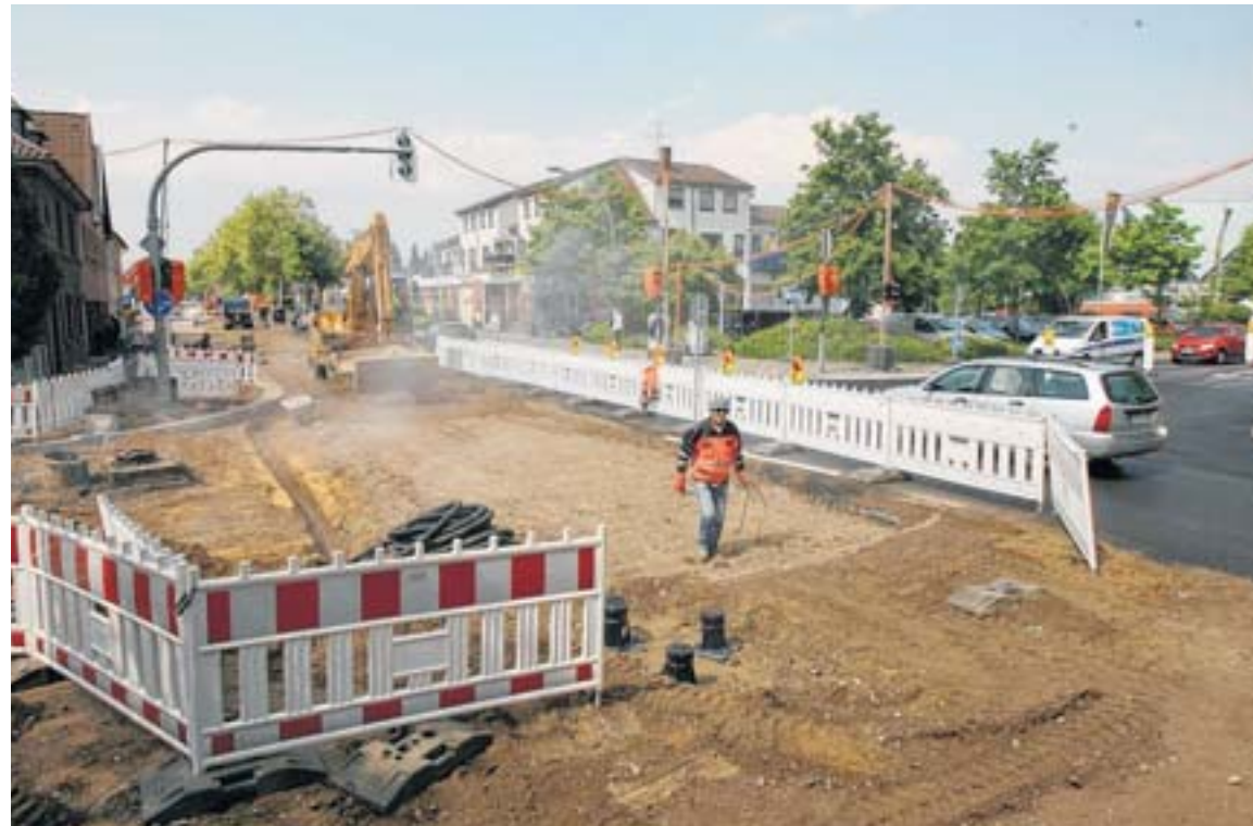
Solche Bilder (wie hier vom Mai 2010 in Höhe der Einmündung Im Bachgrund) gehören nun der Vergangenheit an.
